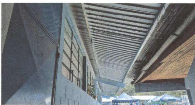
Foto 5: Sustrucción de estructura de metal de techo del módulo de 2 aulas donde se cambió la lámina.
