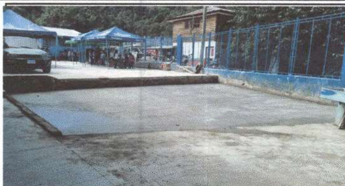
Foto 2: Sustrucción de piso de torta de concreto deteriorado por el paso del tiempo.
