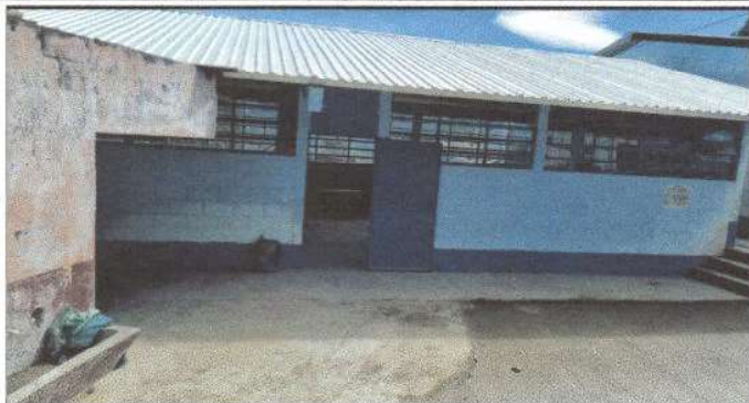
Foto 1: Sustrucción de techo de un módulo de dos aulas.
