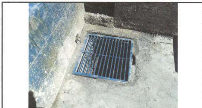
Foto 3: sustitución de caja No. 1 de registro, incluye sustitución de tubos de 6 pulgadas.
