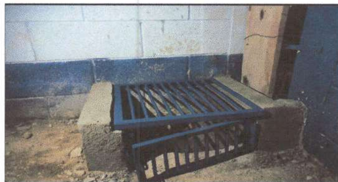
Foto 4: sustitución de caja No. 2 de registro que incluye sustitución de tubos de 3 pulgadas.
